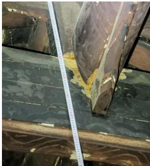
木构残损状态测绘调研
